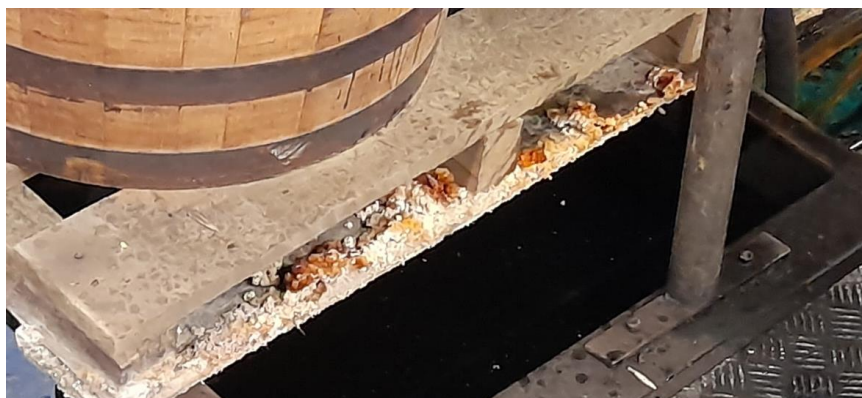
Fuente: Registro fotográfico del 26 de junio de 2023, bodega de añejamiento #4.
